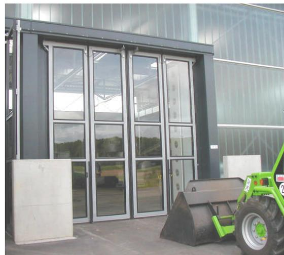
Ausführung mit doppelwandig isolierter VSG-Vollverglasung, Außenmontage
