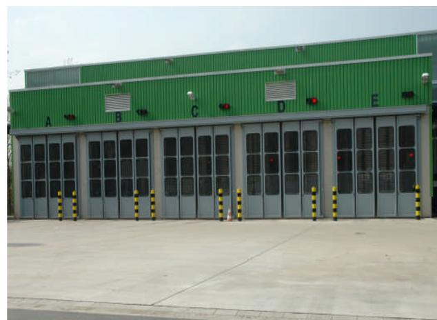
Ausführung mit doppelwandig isolierter Teilverglasung (Rundeckenausbildung), Außenmontage
