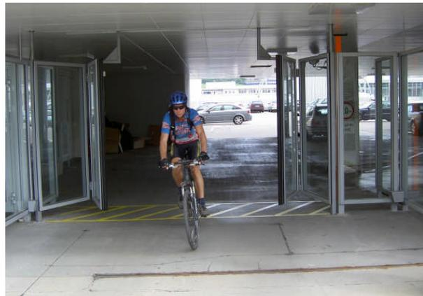
Falttor mit in die Deckenverkleidung eingelassenem Antriebschassis (Sonderkonstruktion), vollverglaste Ausführung ohne Sprossen
