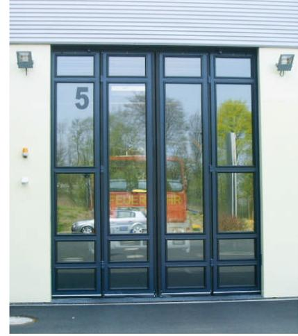
Ausführung mit doppelwandig isolierter VSG-Vollverglasung, Innenmontage
